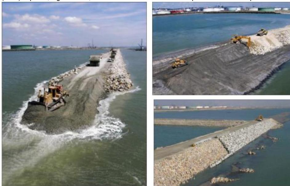
Depuis cette digue provisoire, les différentes couches de l'ouvrage seront réalisées par moyens terrestres (camions, pelles, ...) sur deux fronts d'avancement vers le nord-ouest et vers le sud-est. Les engins terrestres seront chargés de :
