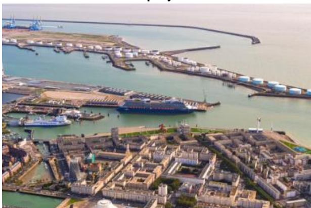
Démarrage des travaux
