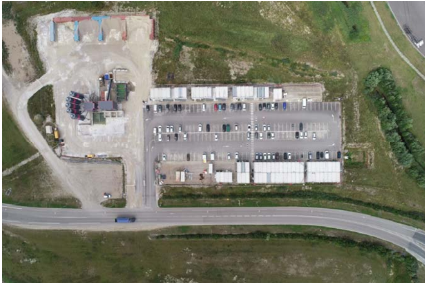
Figure 79 : Vues de la base-vie sur la zone "E" prévue pour le chantier
