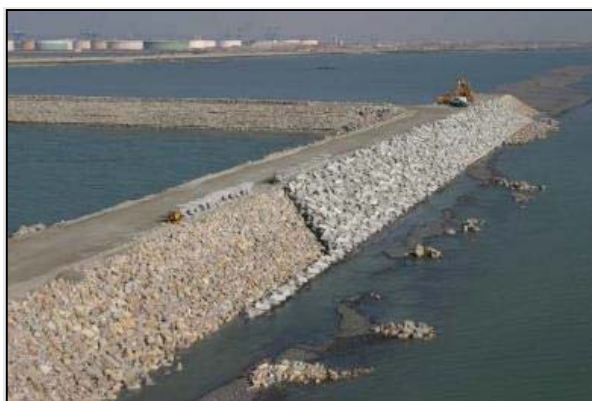
Figure 66 : Mise en place des couches d'enrochements (gauche) et d'acropodes (droite)
