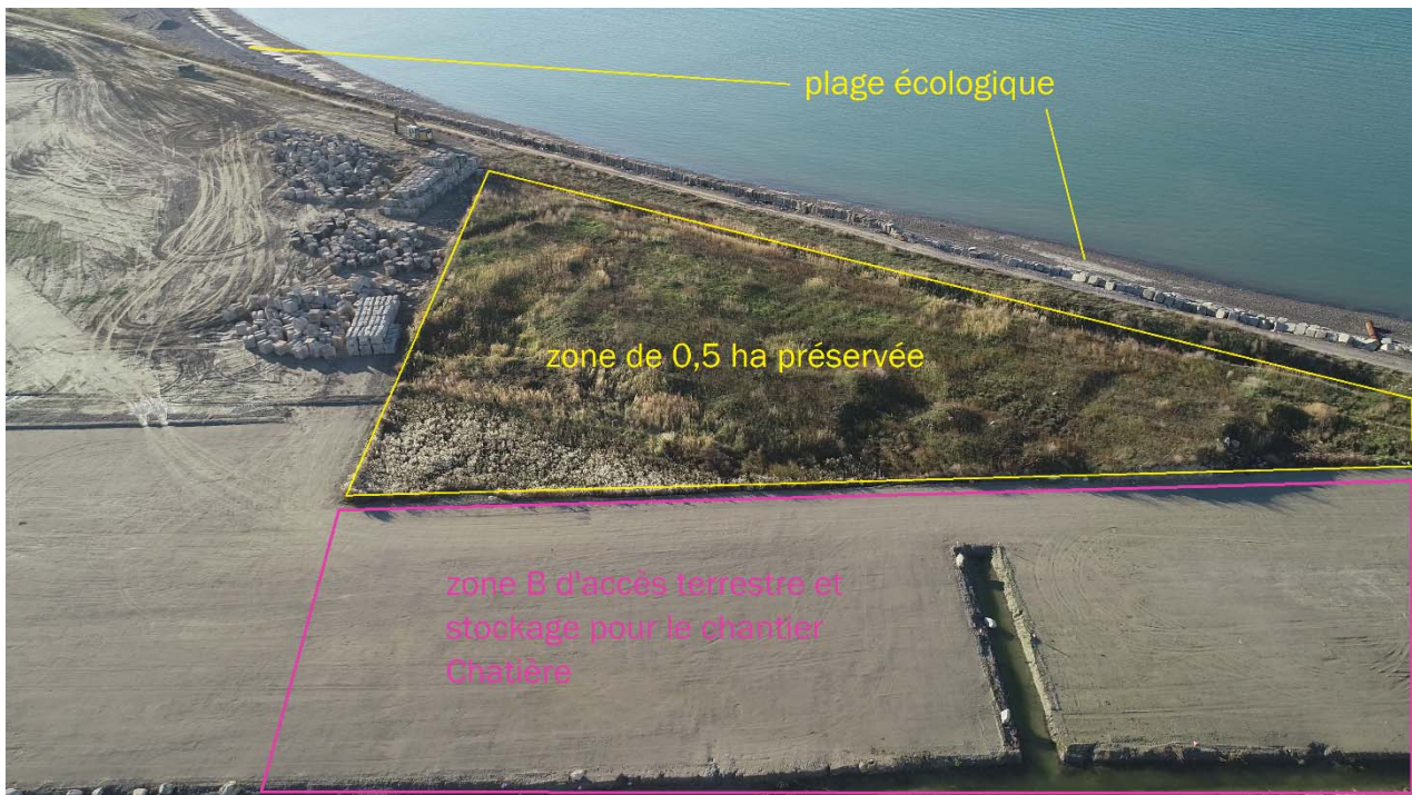
Figure 83 : Travaux en cours en Novembre 2021 sur la « zone B » (photo : SBF – EUCLYD)
