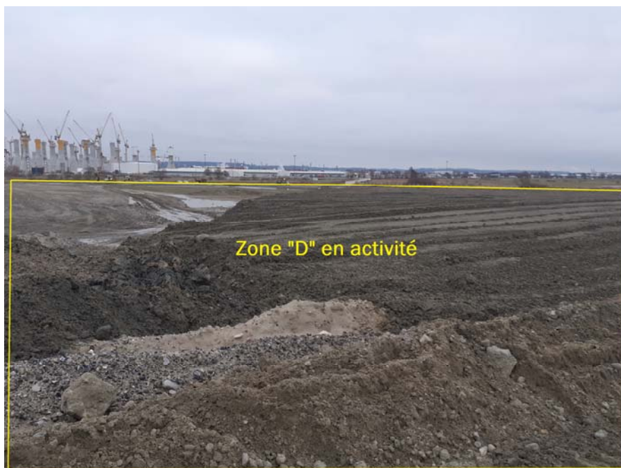
Figure 84 : Travaux en cours en Décembre 2021 sur la « zone D » (photo HAROPA PORT)
