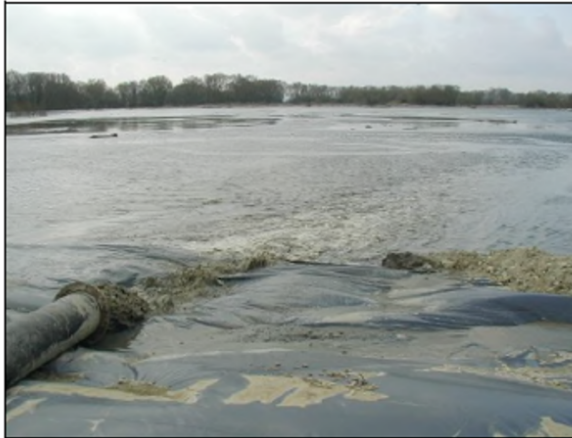
Figure 57 : Illustration d'un refoulement hydraulique par conduites
